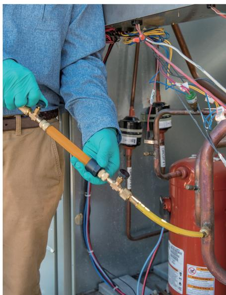
蛍光剤で冷媒ガス漏れをピンポイントキャッチ
