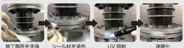
施工箇所を洗浄    シール材を塗布    UV照射    速硬化
